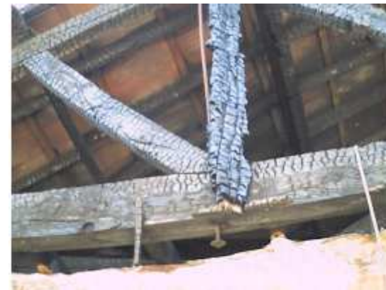
Comprobación de estructura de madera quemada en incendio
