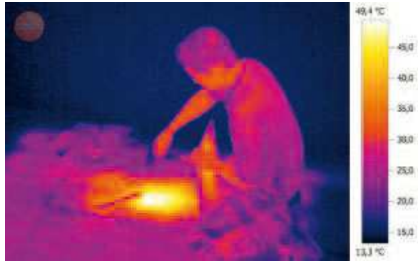
Localización fuga de agua
